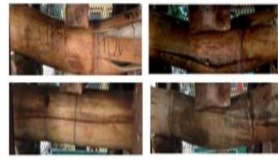
(p) Actual Flexural Failures
